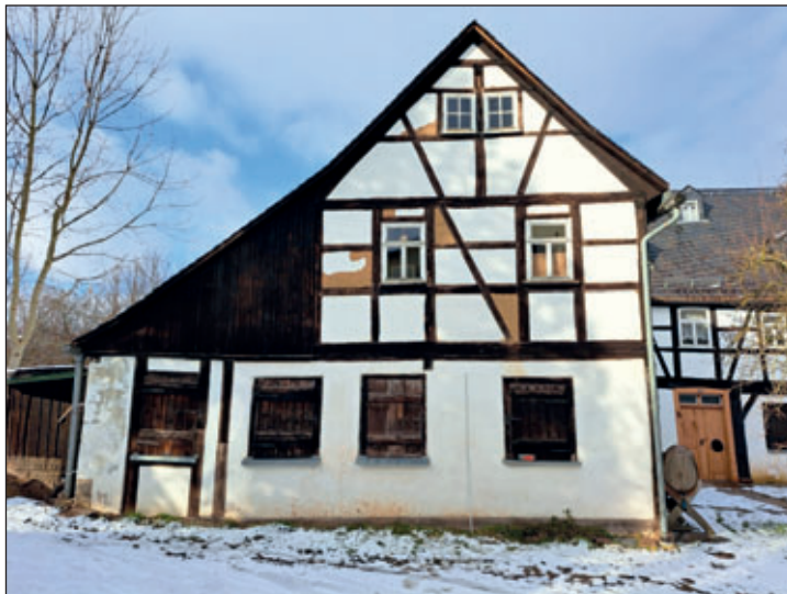
Zustand vor der Sanierung
