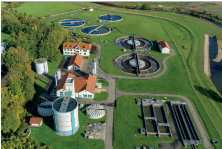
Die größte Kläranlage der Wasserwerke Zwickau ist die Zentrale Kläranlage Zwickau.
