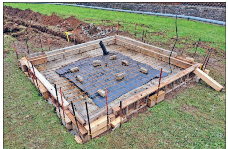
Der Fundamenteinbau am Standort.
